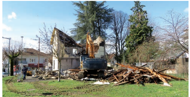
Démolition de la Maison Therme
