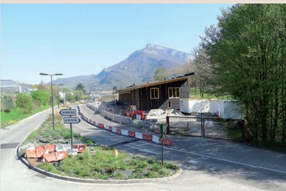
Nouveau centre d'entretien de la DIR
