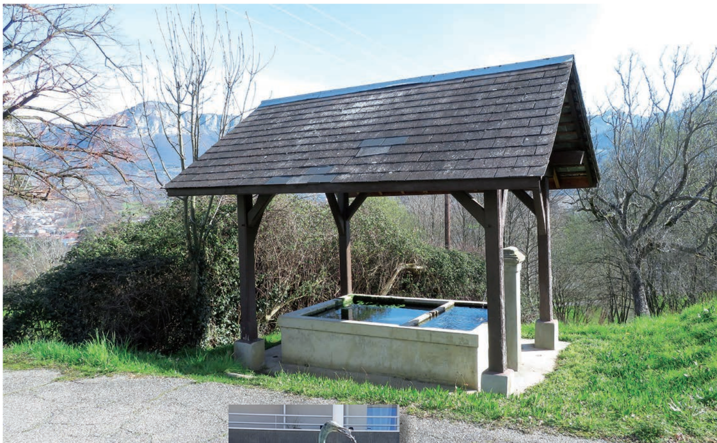
Lavoir Rue des Myosotis
