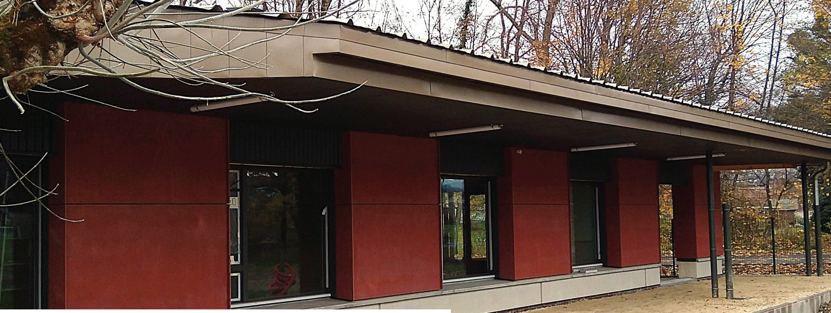
Réhabilitation de l'école de l'Albanne - futur réfectoire
